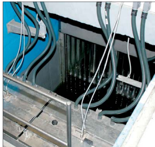
Рис. 8. УФ-модули в канале
