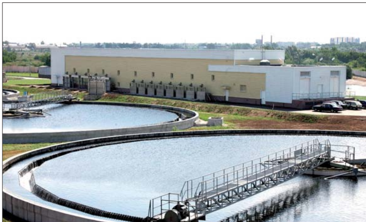
Рис. 4. Здание блока УФ-обеззараживания на Ново-Люберецких очистных сооружениях (на заднем плане)
